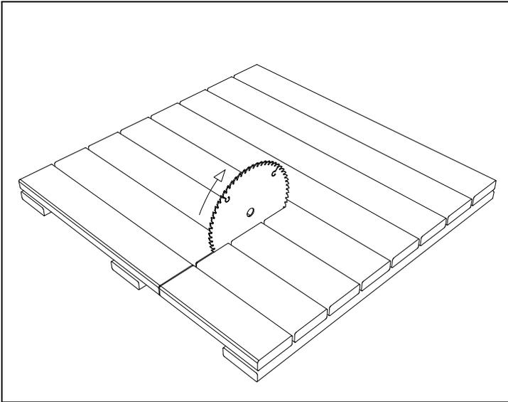
1. DESPUÉS DE MEDIR, CORTE EL TAMAÑO DESEADO CON UNA HOJA DE SIERRA DE CARBURO DE ALTA CALIDAD. CORTE DESDE LA PARTE SUPERIOR COMO MUESTRA LA IMÁGEN SI UTILIZA UNA SIERRA DE MANO, SI UTILIZA UNA SIERRA DE MESA DE VUELTA A LA BALDOSA PARA CORTARLA
