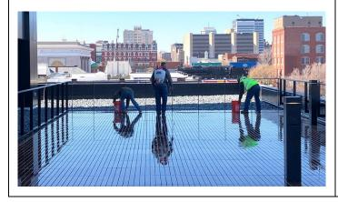
6: Usando una escoba o cepillo no metálico, trabaje la solución de limpieza en la cubierta, restregando a lo largo de las baldosas de madera.
