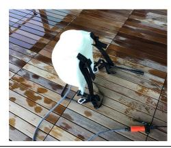
11: Deje que la solución abrillantadora repose en la cubierta durante 30 – 60 minutos o hasta que se seque. Luego, enjuague bien el deck y sus alrededores.
