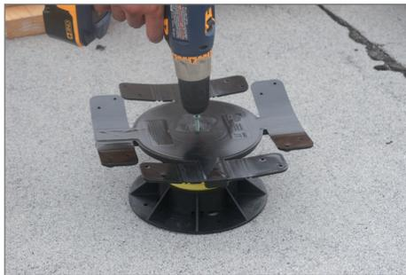
2. Atornille el Joist Top al pedestal usando el tornillo provisto por Bison.
