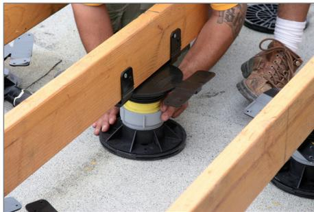
5. Los pedestales Bison se pueden ajustar en altura incluso después de que la viga se haya asegurado a los Joist Tops
