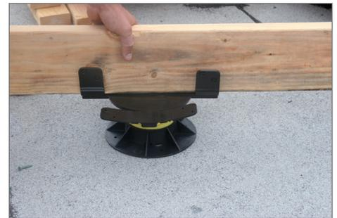
3. Coloque la viga (2x o 4x) encima del Joist Top
