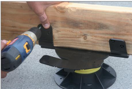
4. Doble las solapas del Joist Top hacia arriba para que coincidan con la viga. Sujete mecánicamente las solapas a la viga con tornillos n.º 8.
